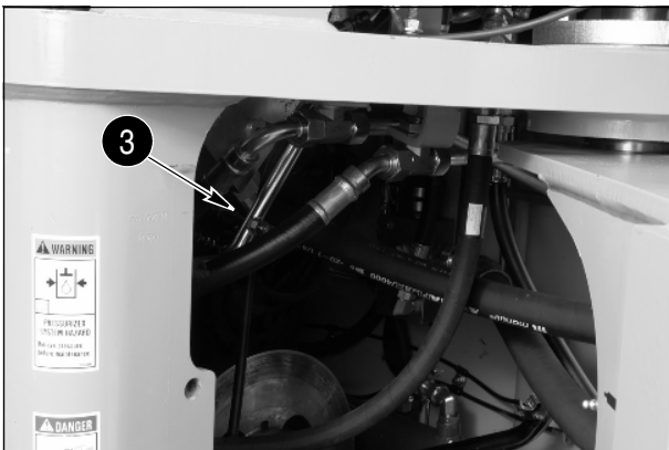
3. TOMA DE PRUEBA DEL ACUMULADOR DEL FRENO DELANTERO
