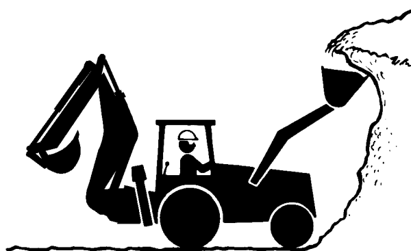
Retiro de material sobresaliente
